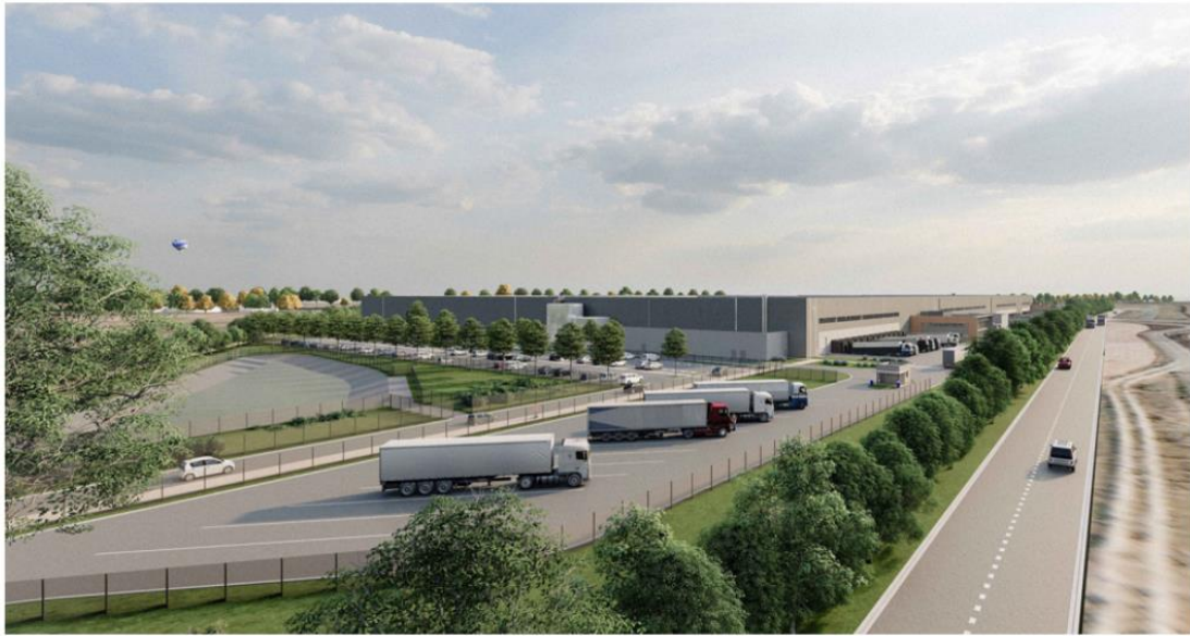
1 | Vue depuis l'entrée N°1
